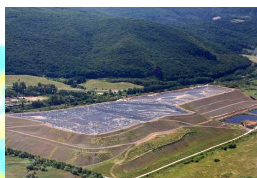
Fig. 4 Sludge bed in year 2011 Žiar n. Hronom
